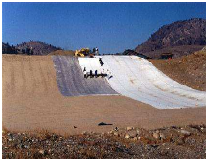
Слика 5.6. Постављање геомембране и геотекстила
