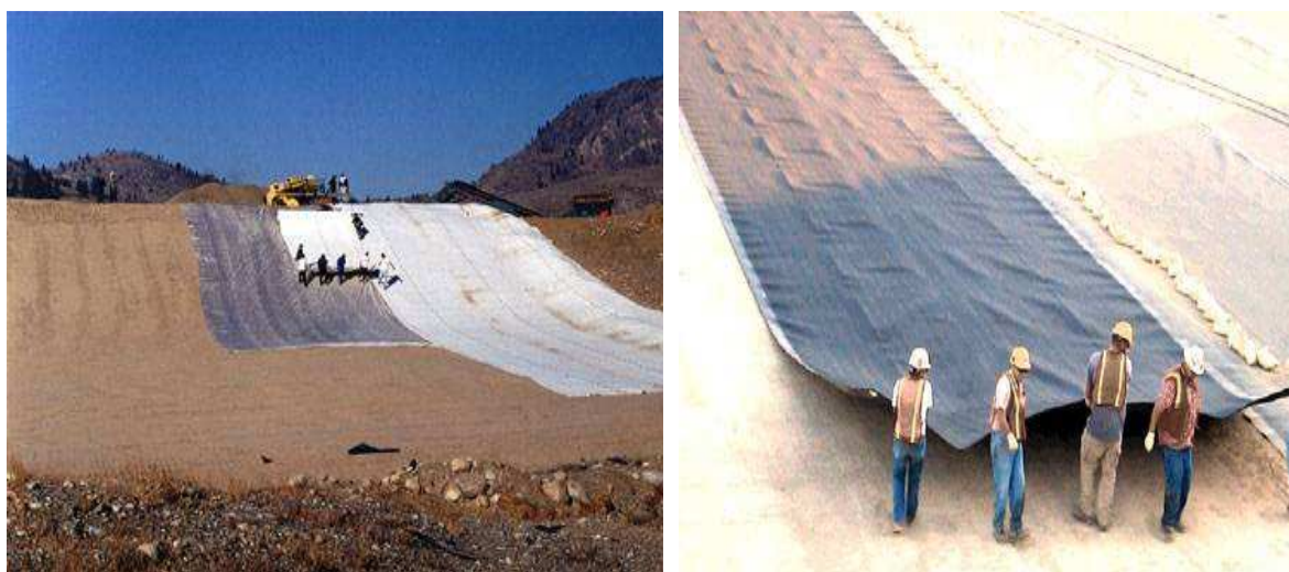
Слика 5.22. Постављања доње непропусне фолије.
